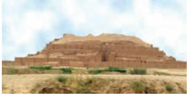
شکل ۱-۶- معبد چغازنبیل در ۶۰ کیلومتری جنوب شرقی دزفول که حدود ۴۰۰۰ سال پیش با استفاده از خشت، آجر، آجرهای لعاب‌دار، اندود گچی و ملات قیر ساخته شده است.
