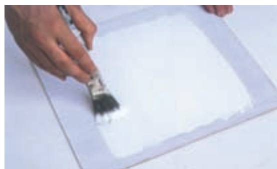
تصویر ۲- تخته چند لایه به وسیله ماده نفوذناپذیر پوشیده شده است. سعی کنید ماده نفوذناپذیر را یک بار از یک سمت و پس از خشک شدن، از سمت دیگر بر روی سطح، بمالید.
