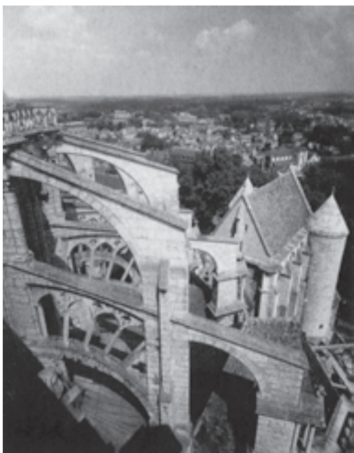
تصویر ۳۴— حایل‌های توخالی دیوارها در معماری گوتیک
