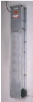
شکل ۲۶-۳- دماسنج کنترل‌کننده پمپ آب
