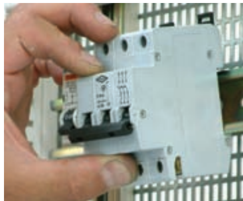
شکل ۹-۲- طرز قرارگیری فیوز مینیاتوری روی ریل
