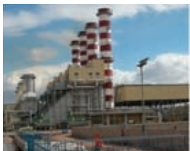
نیروگاه سیکل ترکیبی قم
