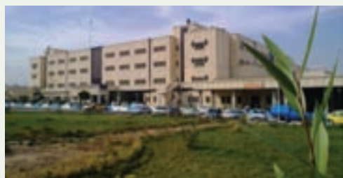
شکل ۱۷-۶- بیمارستان فوق تخصصی بعثت - همدان
