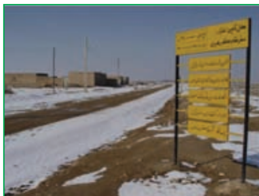
شکل ۶-۶- پروژه احداث راه روستایی - آق تپه
