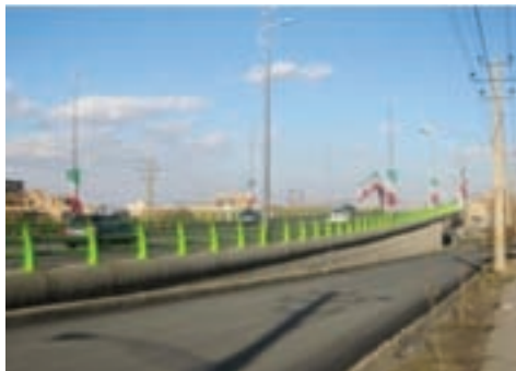
شکل ۱۰-۶- پل روگذر رسالت - همدان
