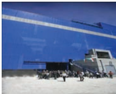
شکل ۱۸-۵- مجتمع فولاد ویان - کبودرآهنگ
