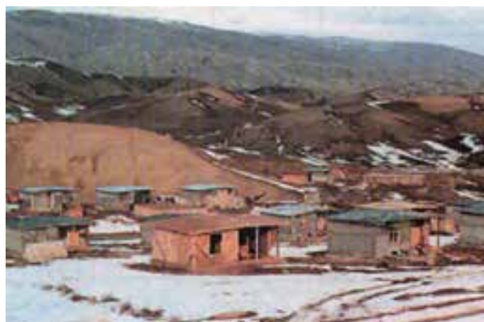
شکل ۱-۶۱- بازسازی روستای زلزله زده توپ چنار شهرستان مانه و سملقان با استفاده از
