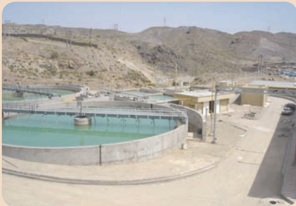
شکل ۱-۶۰- تصفیه خانه مجتمع مس سرچشمه
