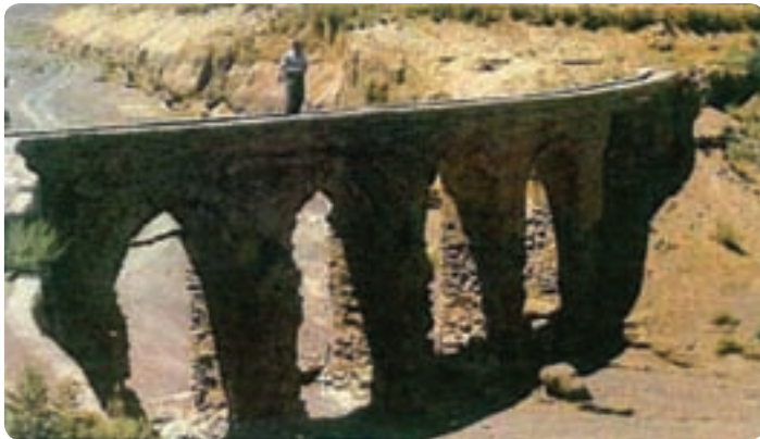
شکل ۳۶-۱- پل انتقال آب قنات بر روی رود دوکالی خرائق
