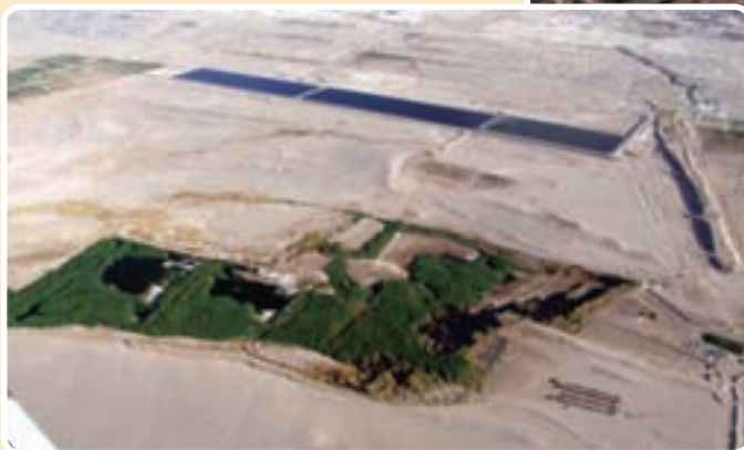
شکل ۴۰-۱- تصویر هوایی برکه‌های تصفیه خانه فاضلاب شهر یزد
