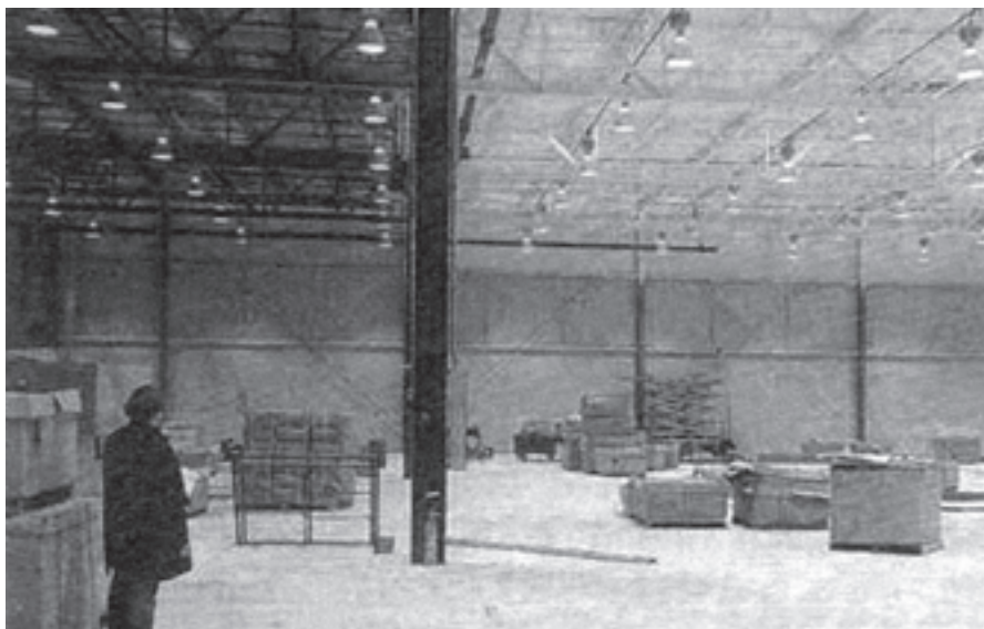
شکل ۲۴-۳ سیستم روشنایی عمومی
