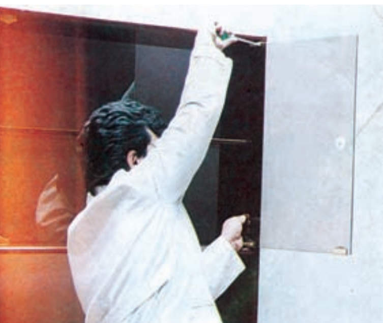
شکل ۱۰-۱۳- نحوه نصب درهای شیشه‌ای کتابخانه
