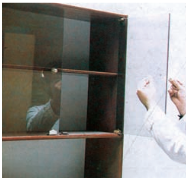
شکل ۱۲-۱۳- نحوه نصب دستگیره در شیشه‌ای
