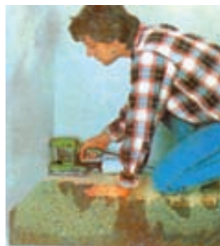
شکل ۱۲-۲۲- تمیز کردن گوشه کار با سنبلاده خشن
