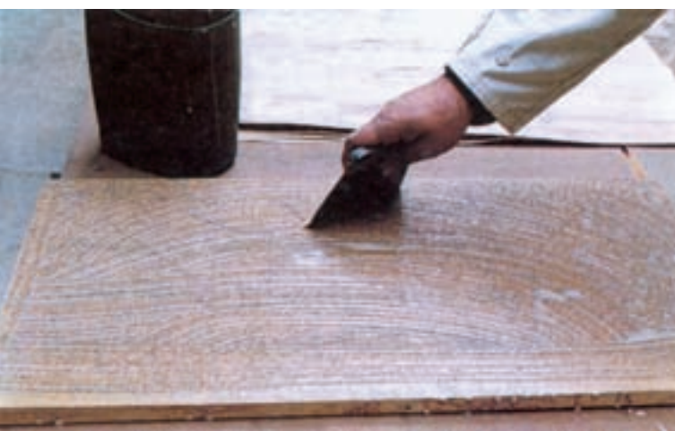
شکل ۱۱-۷- نحوه پخش کردن چسب به طور یکنواخت روی سطح کار با کاردک مخصوص
