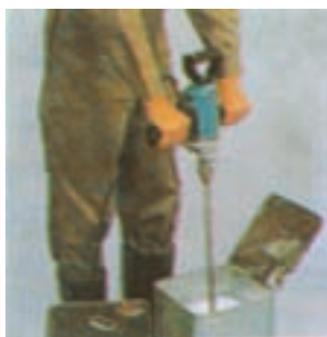
شکل ۸-۷- نحوه مخلوط کردن مواد چسب با دریل برقی
