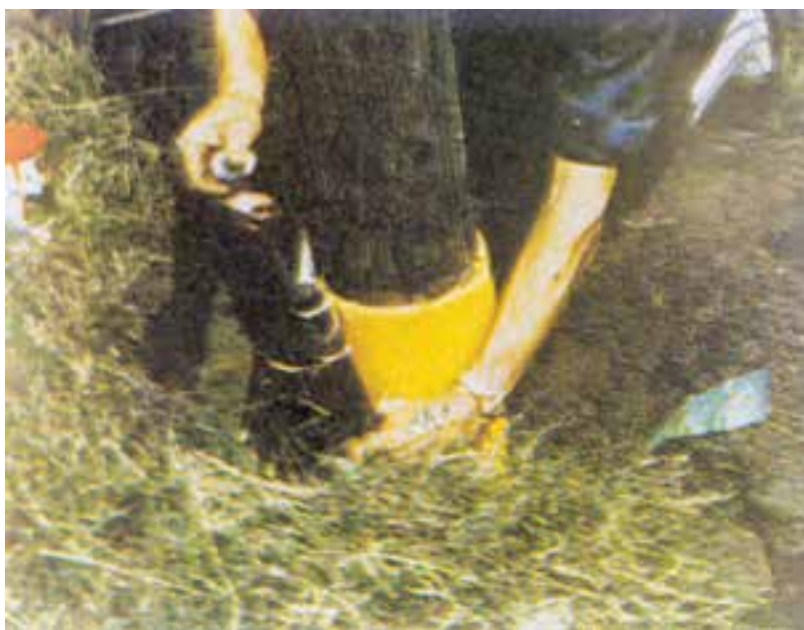
شکل ۱۱-۶- روش بانداز کردن برای تیرهای نصب شده کهنه
