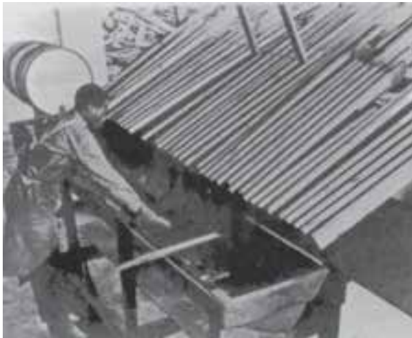
شکل ۹-۶- روش ساده آغشته کردن چوب‌های بریده‌شده با مواد حفاظتی محلول در آب
