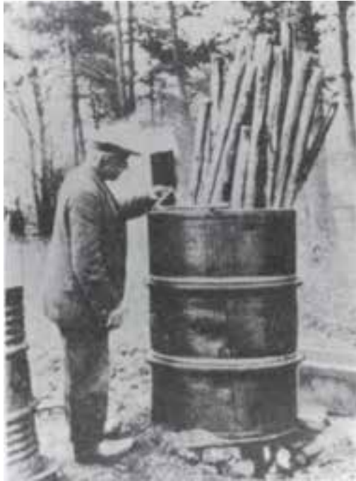
شکل ۸-۶- روش ساده آغشته کردن پایه‌های چوبی حصارکشی در داخل بشکه
