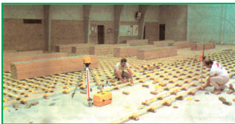
شکل ۳-۵- طریقه زیرسازی جهت نصب پارکت
