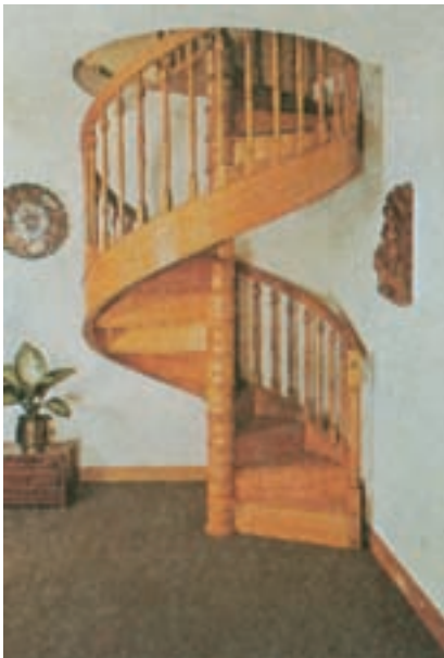
شکل ۷-۷- برای خم کردن چوب باید آن را مرطوب کرد. مقاومت خمشی چوب مرطوب کم است.
