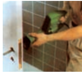
شکل ۲-۱۳- برش جای قفل با اره افقی چکشی
