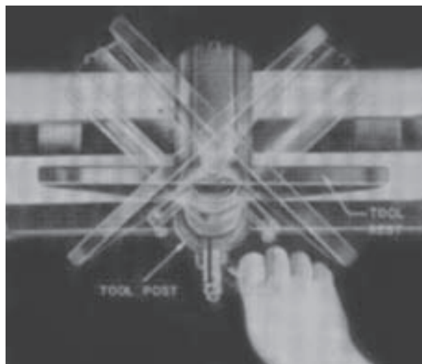
شکل ۱۳-۵- تکیه‌گاه مغار طراحی می‌تواند در حالت‌های مختلف قرار گیرد.
