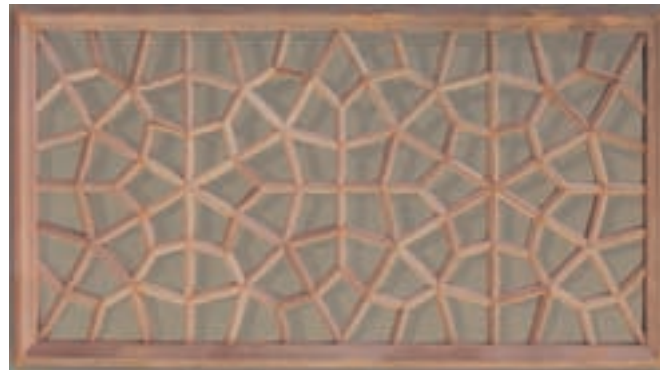
شکل ۹-۸۸- اتصال متقاطع در گره چینی یک پنجره.
