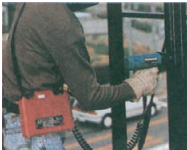
شکل ۱۲-۳۶- نحوه‌ی استفاده از دریل بوکس با باتری شارژ شونده
