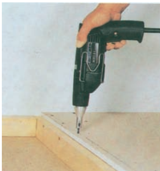
شکل ۱۲-۱۲- نحوه‌ی کاربرد دریل پیچ‌گوشتی برقی دستی ساده
