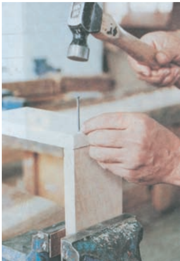
شکل ۱۲-۱۱- نحوه‌ی میخ‌کوبی
