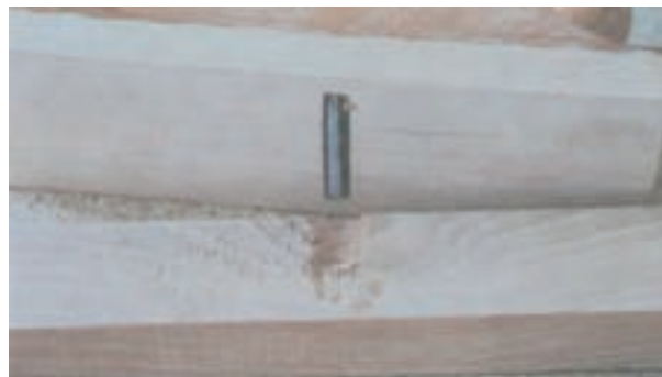
شکل ۲۲-۵- کندگی در سطح چوب
