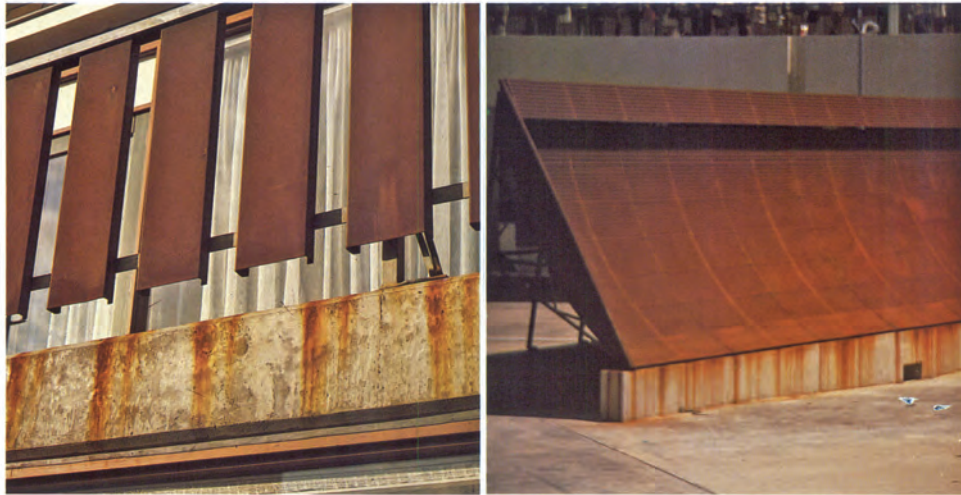
شکل ۷-۷. سطح زنگ‌زده ورق‌های آهنی در اثر قرار گرفتن در شرایط اتمسفر مرطوب
