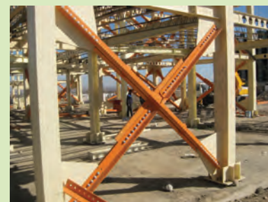
اجرای اتصال بادبندها از نوع پیچی
