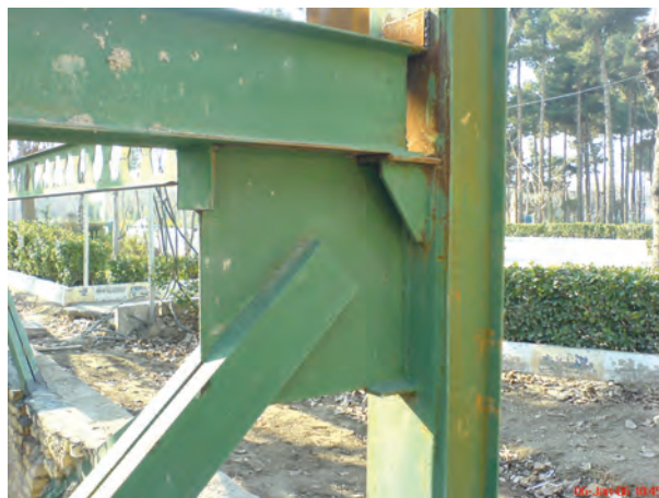
شکل ۳-۲- اتصال جوشی در سازه فلزی ساختمان
