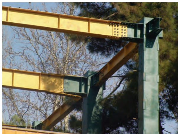
شکل ۳-۴- اتصال پیچی در سازه فلزی ساختمان
