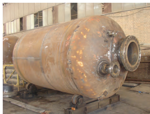
شکل ۳-۳- ساخت مخزن تحت فشار
