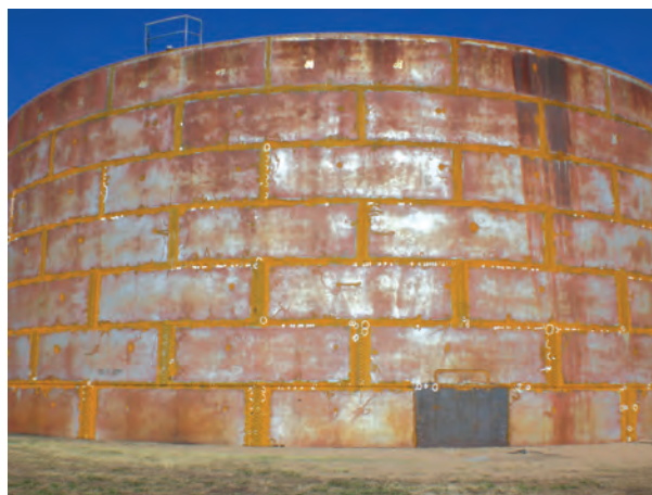
شکل ۳-۱- ساخت مخزن ذخیره سوخت با ورق های فولادی
