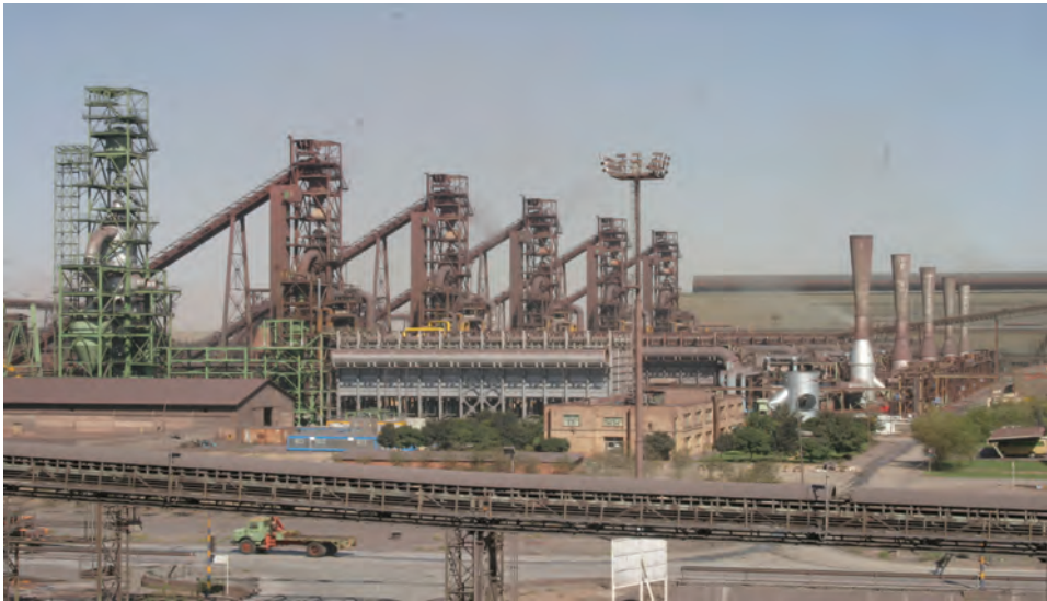
شکل ۲-۱۰- نمایی از کوره‌های احیاء مستقیم مجتمع فولاد مبارکه اصفهان
