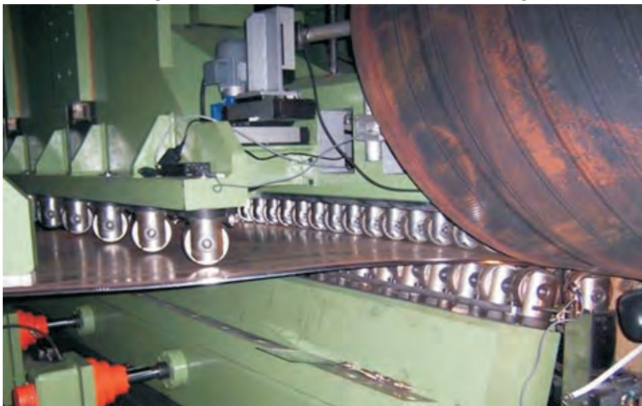
شکل ۴-۲۳-ج شکل دهی لوله‌ها
