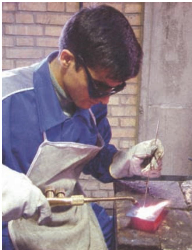
شکل ۸-۴۱ جوشکار در حال جوشکاری با سیم جوش
