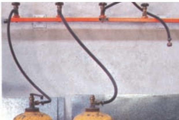
شکل ۱۹-۲ پست مرکزی استیلن
