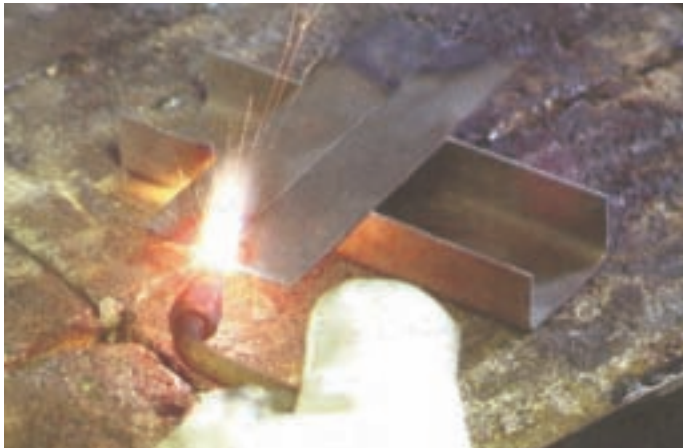
شکل ۸-۴۸-۱ خال جوش زدن در طرفین اتصال
