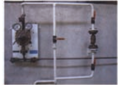
لوله کشی پست مرکزی گاز اکسیژن
