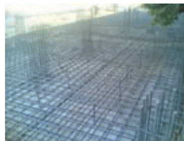
شکل ۱-۱۴ یکی از انواع کامپوزیت‌ها بتن مسلح است
