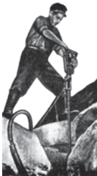
شکل ۹-۱۰- وضع ناپایدار کارگر کوه‌بر بر روی گرانیت
