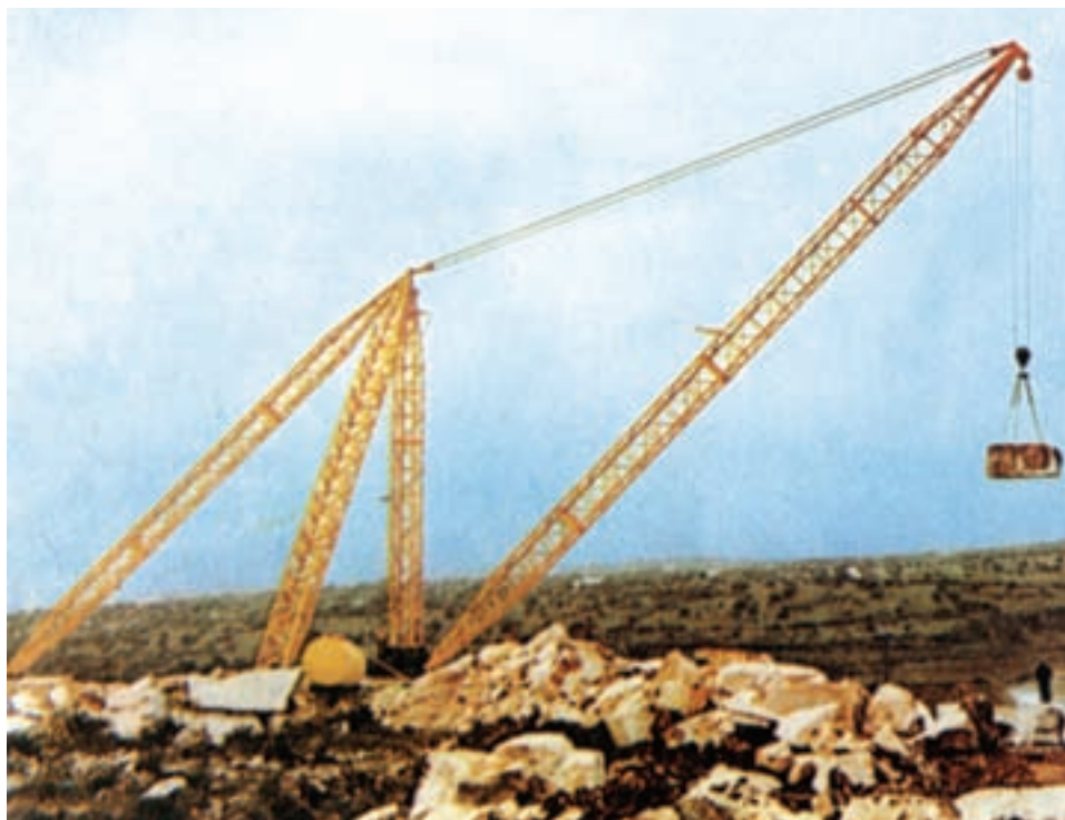
شکل ۲۲-۵- جرثقیل مخصوص حمل بلوک‌های سنگ استخراجی
