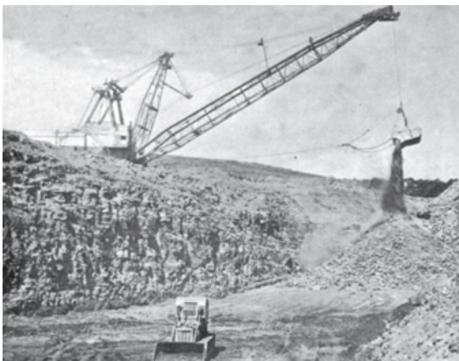
شکل ۲۷-۴- دراگلین در حال کار
