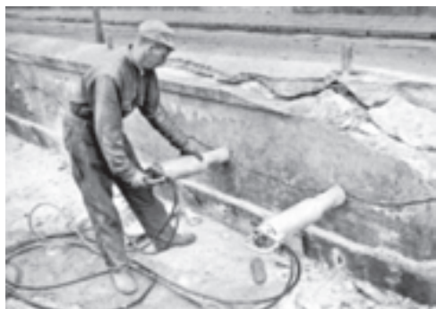
شکل ۷-۵- دستگاه پاس و گوه هیدرولیکی (داردا) و نحوه عملکرد با آن
