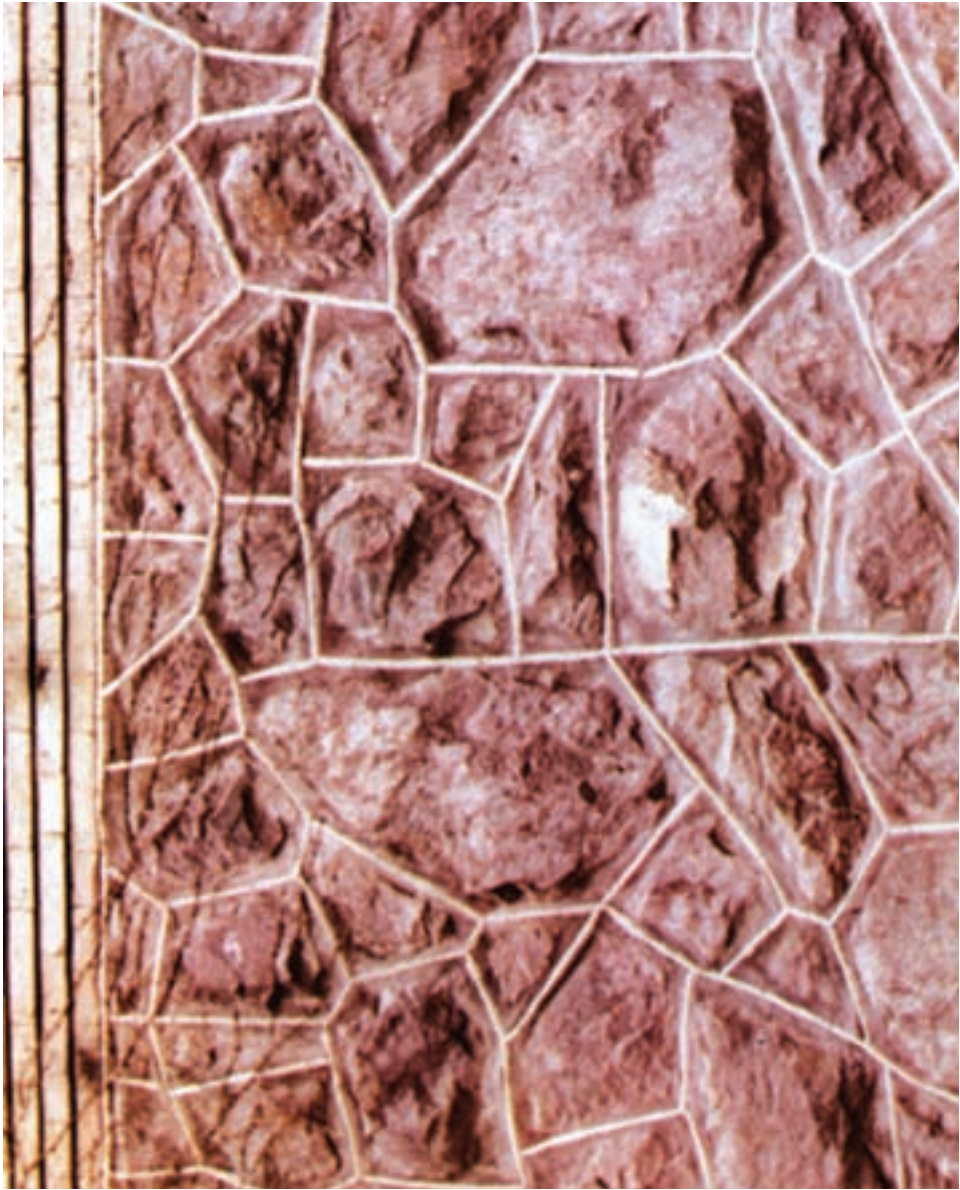
شکل ۲-۵- نمونه‌ای از کاربرد سنگ‌ها در دیوار ساختمان
