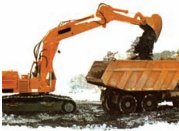
شکل ۲۳-۴- کج بیل در حال حفر کانال
