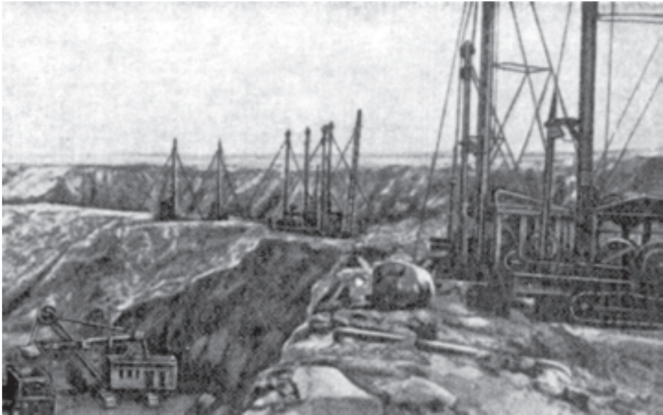
شکل ۴۵-۴- استقرار برج حفاری در امتداد پله‌های حفاری
