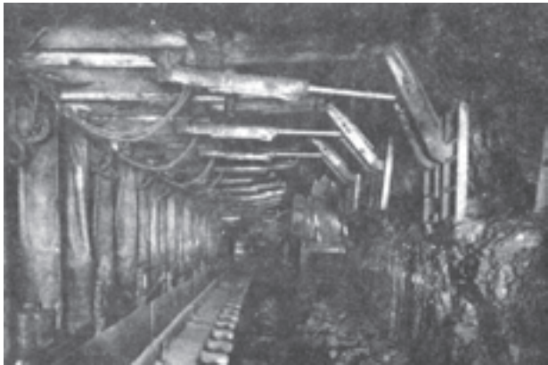
شکل ۴-۳۷- کاربرد ناو زنجیری در کارگاه استخراج
