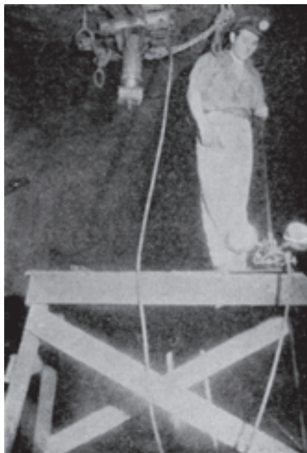
شکل ۱۲-۲۸- نحوه‌ی آزمایش پیچ‌سنگ
