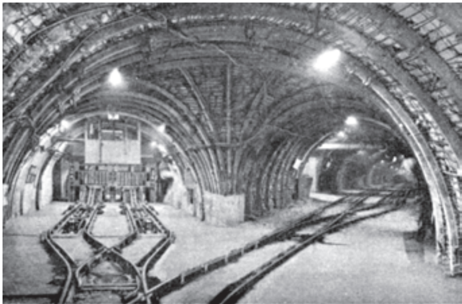
شکل ۱۲-۱۰- دو منظره از دوراهی در تونل ها
