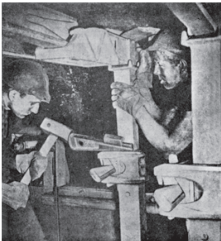
شکل ۹-۸- نحوه نصب پایه‌های فلزی
