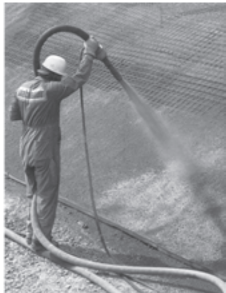
شکل ۷-۳۲- ایجاد یک لایه بتن با سیستم شاتکریت
