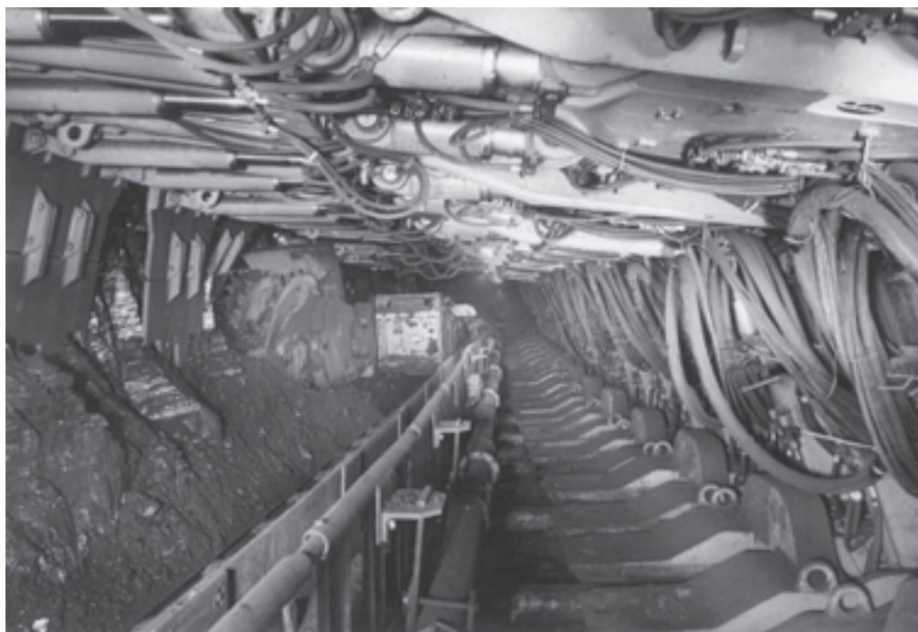
شکل ۹-۲۰- پایه قدرتی در کارگاه استخراج
