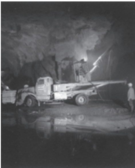
شکل ۷-۳۲- ایجاد یک لایه بتن با سیستم شاتکریت
