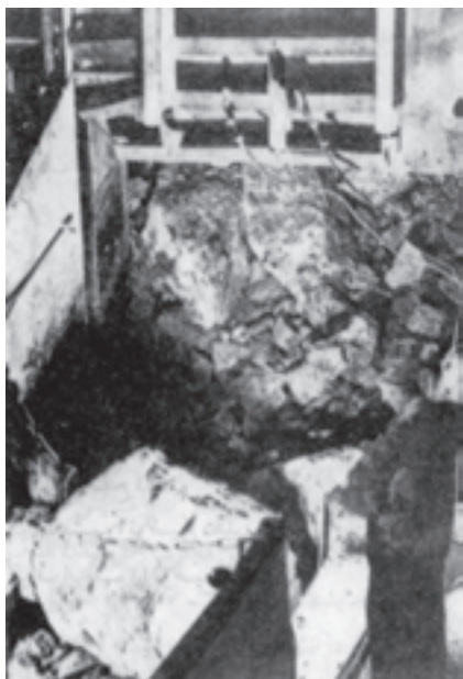
شکل ۳-۴ نحوه‌ی خرد کردن سنگ‌های بزرگ آسبست
