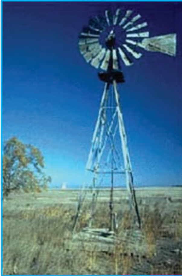
شکل ۱۶-۳ پمپ آب سرچاهی که با انرژی باد کار می‌کند.
