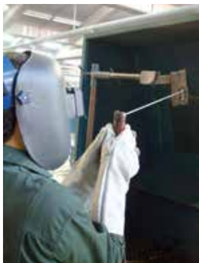
شکل ۱۵-۱۱- جوشکاری سربالا که به صورت پیش‌دستی اجرا می‌شود.
