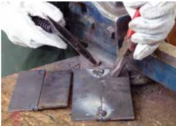
شکل ۹-۸- خال جوش شده قطعات
